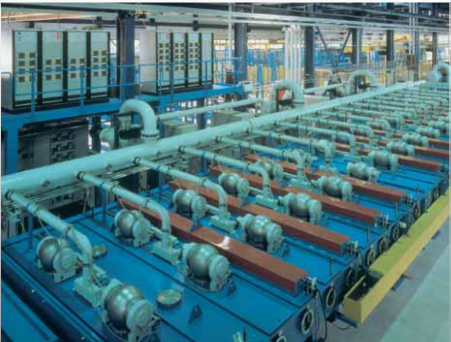
Glasbeschichtung in Lauenförde
